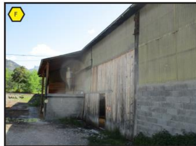
Vue sur la façade Ouest de la scierie
