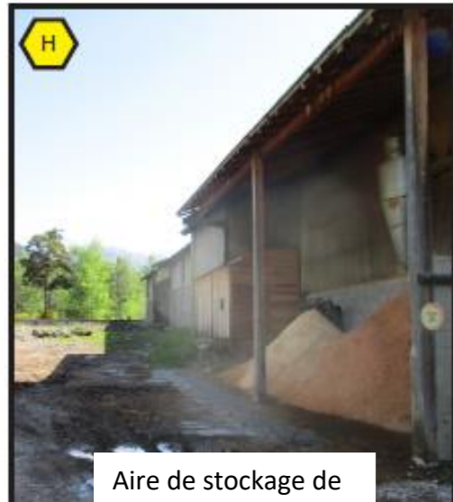
Aire de stockage de la sciure (sous abri, en façade Ouest)
