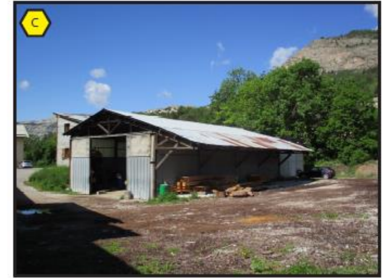
Vue sur l'atelier du site
